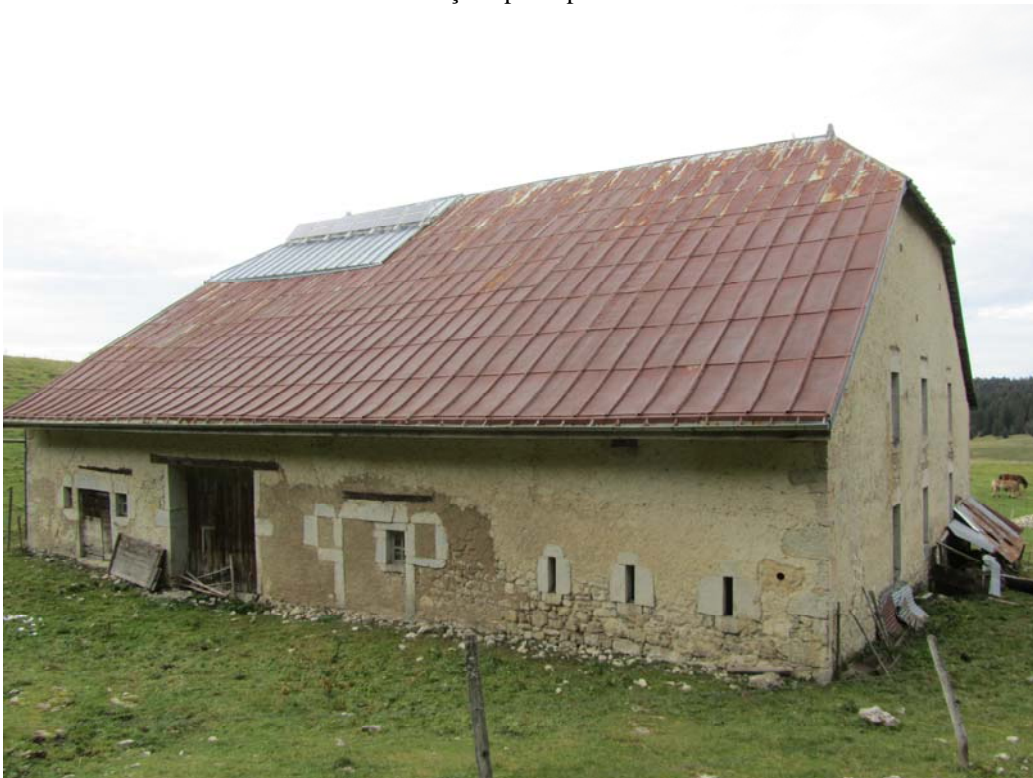
Arrière du bâtiment. Les bornatz, ici comme sur le devant et la façade de bise, semblent prouver l'usage d'une chambre à lait, en conséquence on devait fabriquer du fromage dans la maison.
