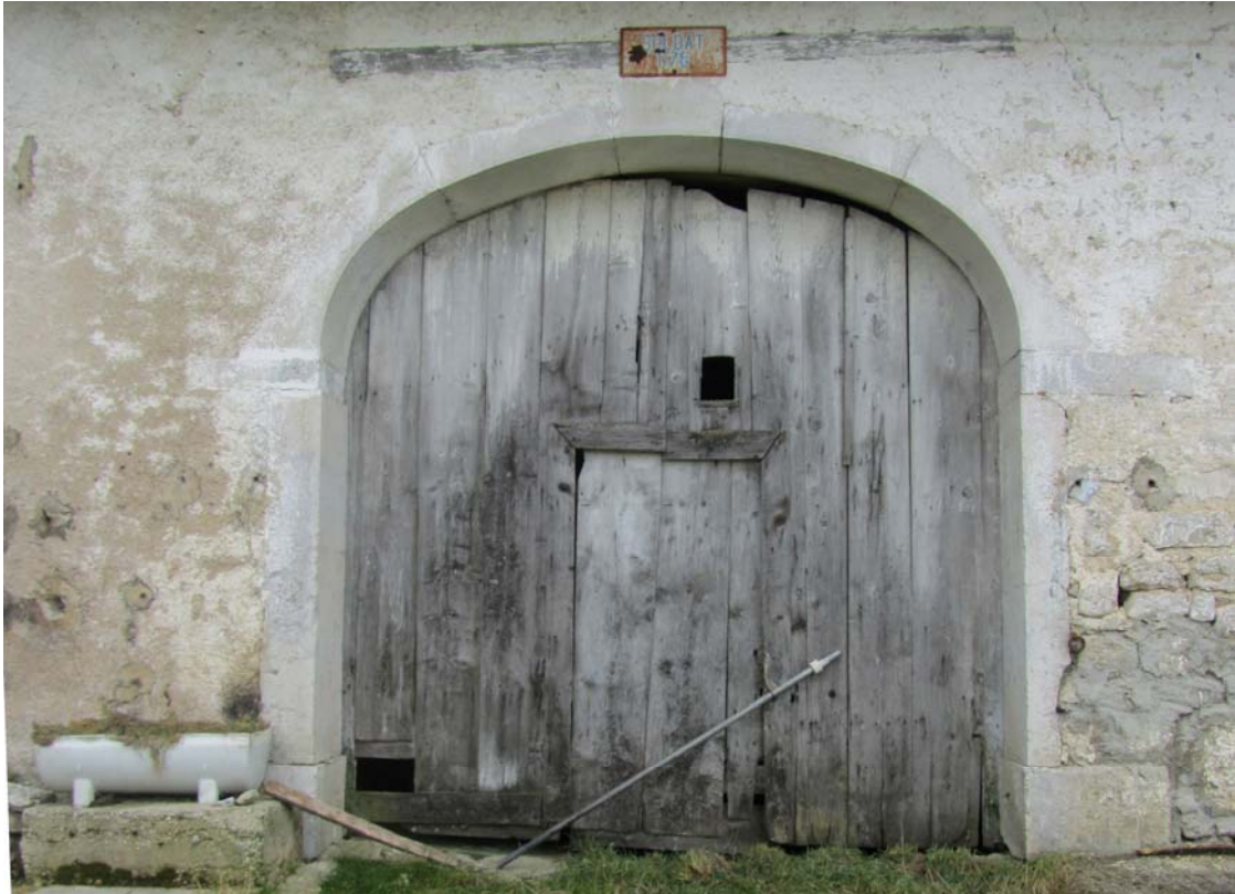
Les belles pierres de taille de la porte de grange et la façade à vent. Ici nécessité absolue de protéger celle-ci.
